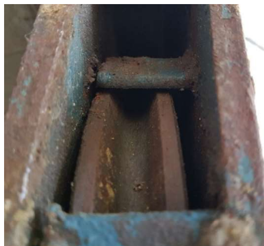
Figura 16 - Detalhe do posicionamento das placas metálicas.
