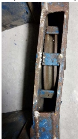
Figura 15 - Polia com três placas metálicas para impedimento do escape do cabo de aço.
