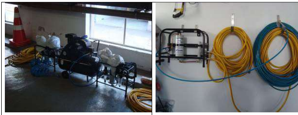
Figuras 19 e 20 – Equipamentos para entrada em espaços confinados com atmosfera Imediatamente Perigosa à Vida e à Saúde – IPVS – adquiridos pelas empresas notificadas
